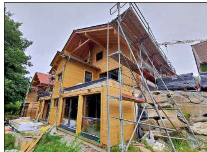
Noch ist hier Baustelle. Im Herbst sollen hier die ersten Urlaubsgäste begrüßt werden.
